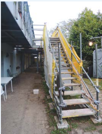
Baumaßnahmen am Wohnprojekt. Sanierung der Balkone, Sommer 2014
